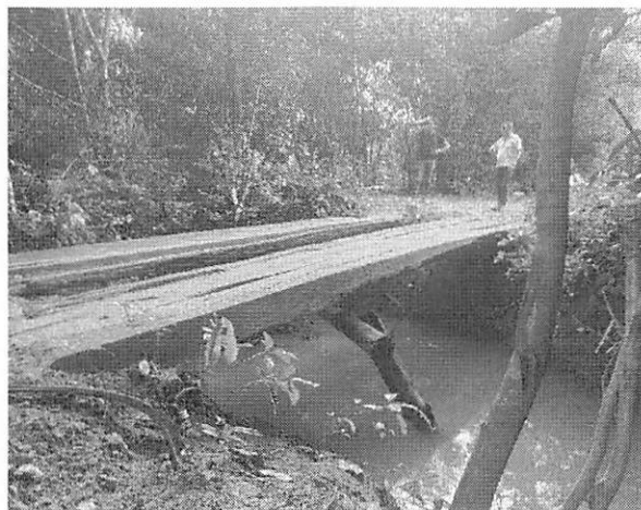
Figura 5: Local da ponte:
