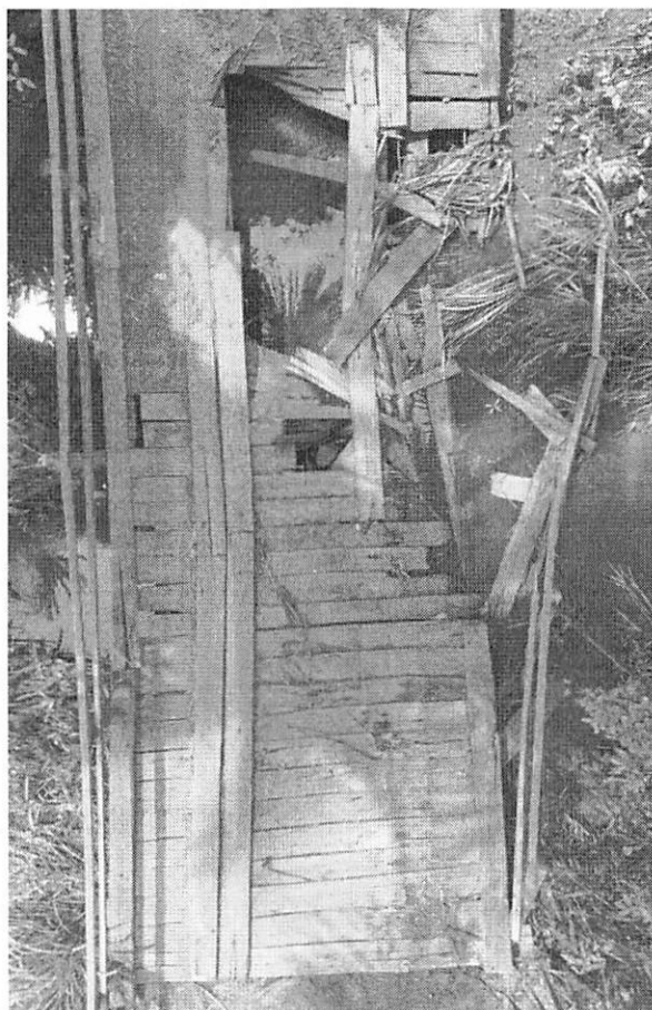
Figura 5: Local da ponte:
