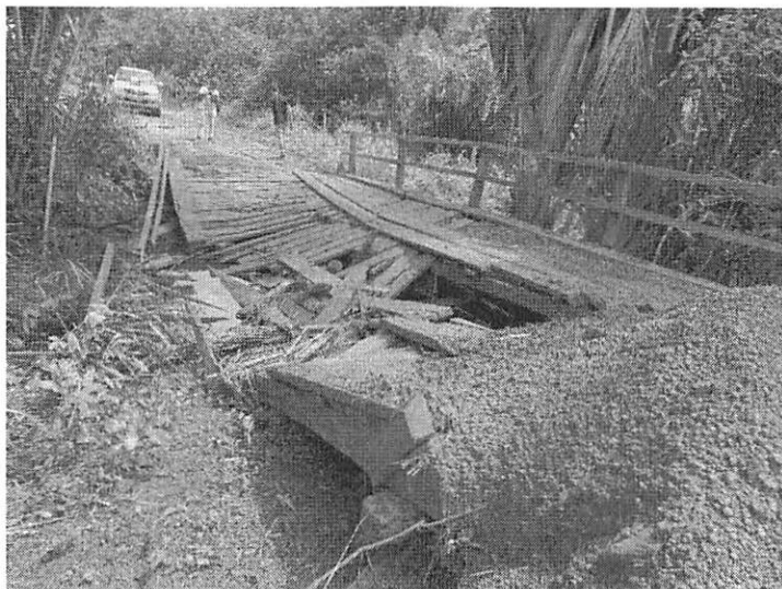
Figura 4: Local da ponte:
