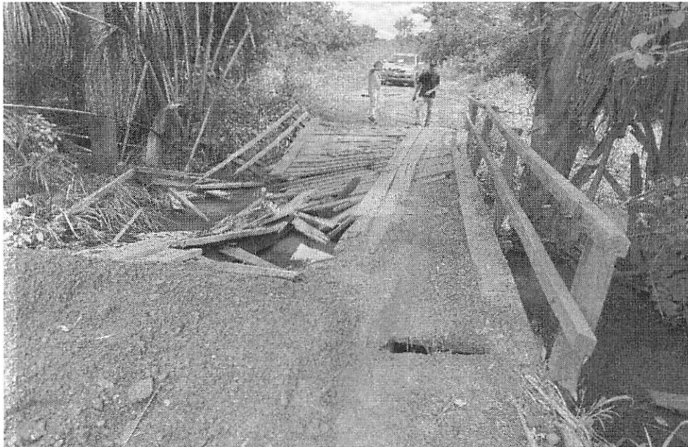
Figura 3: Local da ponte:
