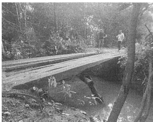
Figura 5: Local da ponte:
