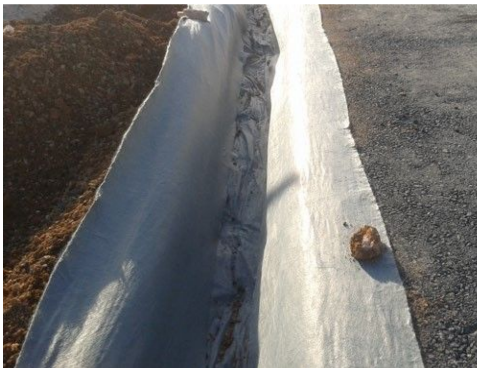
Figura 5 -Colocação da manta geotêxtil.
