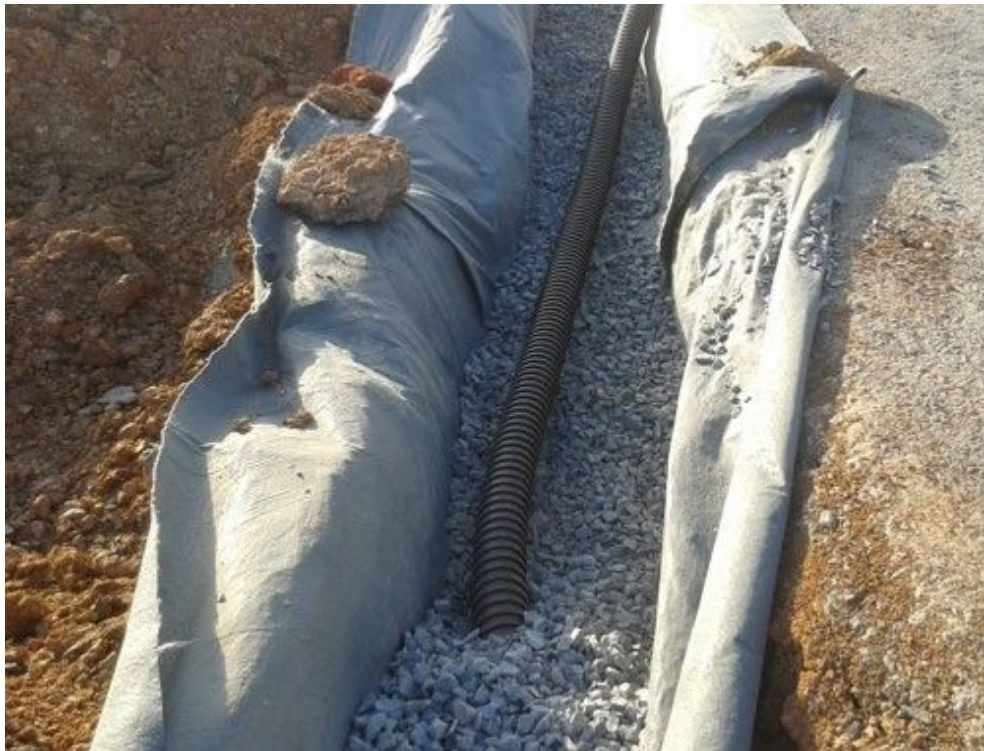
Figura 6 -Colocação da brita sobre a manta geotêxtil.
