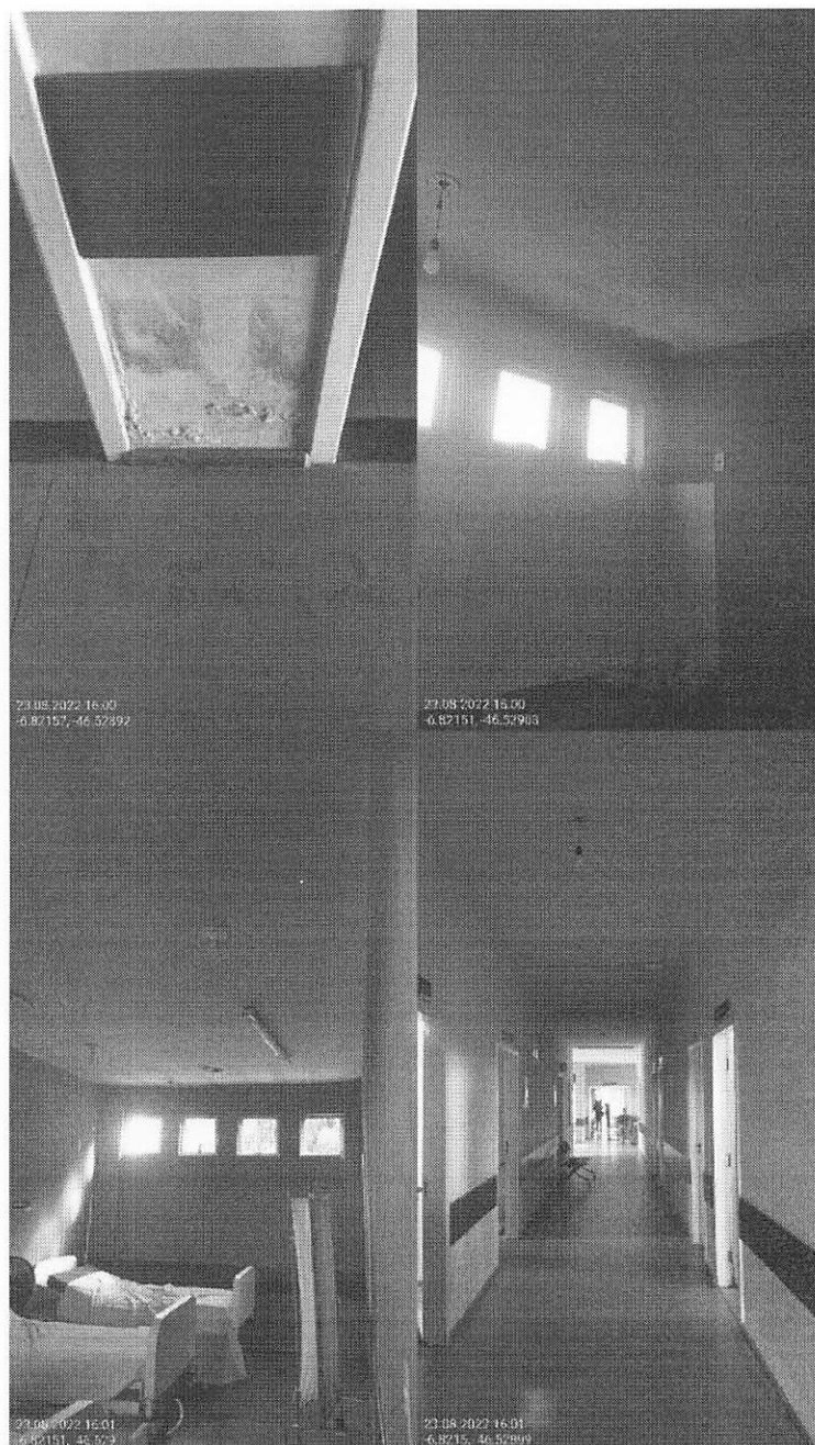
FIGURA 3: PROBLEMAS DE INFILTRAÇÕES
