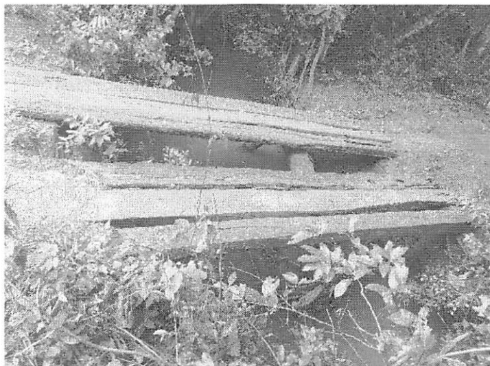
Figura 4: Local da ponte:
