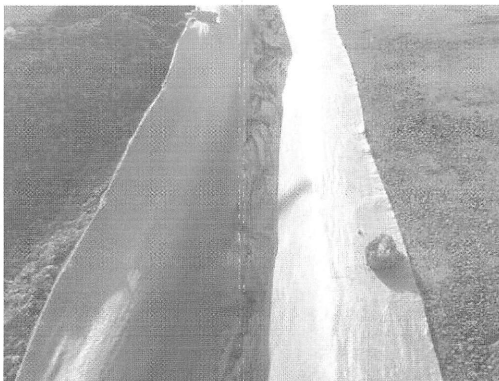
Figura 5 -Colocação da manta geotêxtil.
