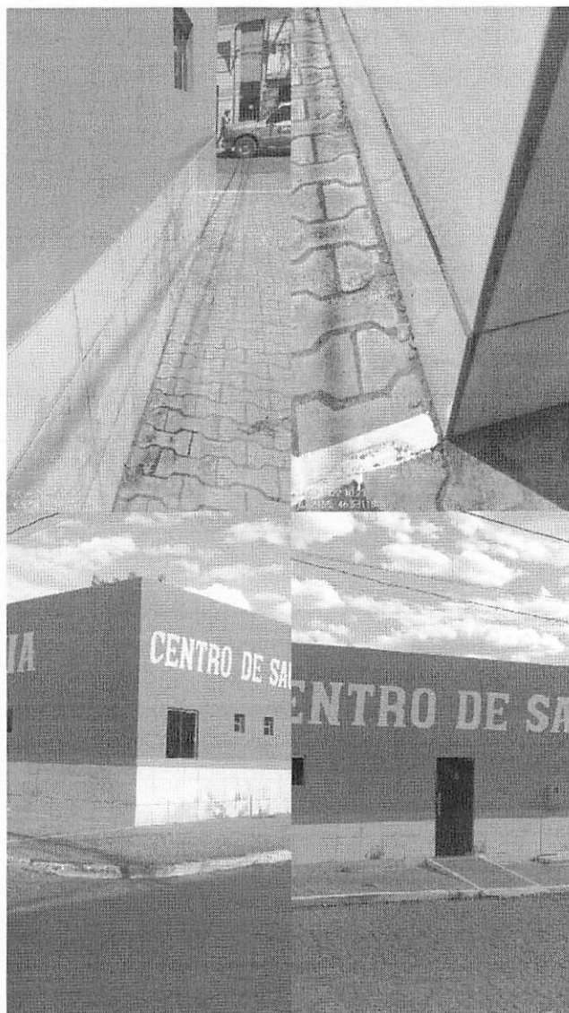
FIGURA 5 – PROBLEMAS DE INFILTRAÇÕES NA FACHADA
