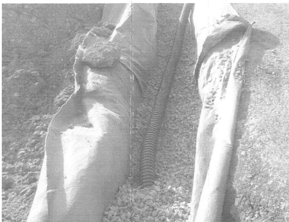
Figura 6 -Colocação da brita sobre a manta geotêxtil.
