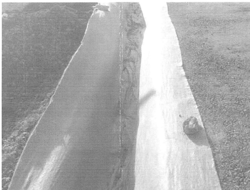
Figura 5 -Colocação da manta geotêxtil.
