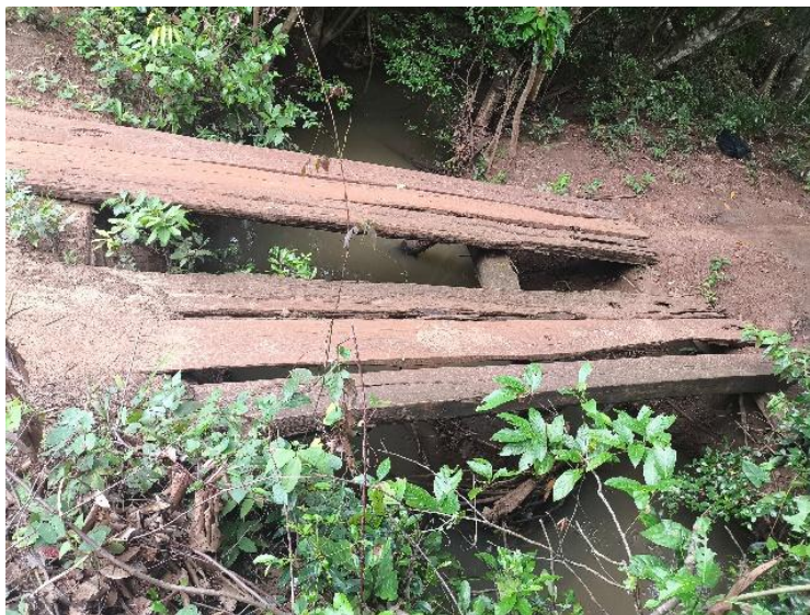
Figura 4: Local da ponte:
