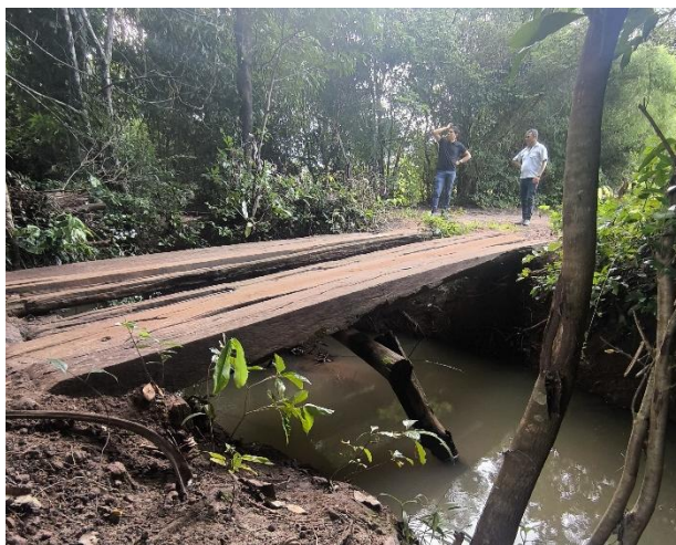
Figura 5: Local da ponte:
